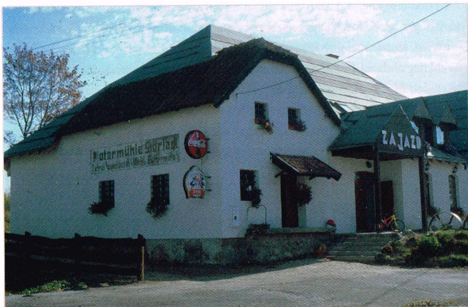
Die ehemalige Mühle von Groß-Stürlack, Foto: Wolfgang Reith
