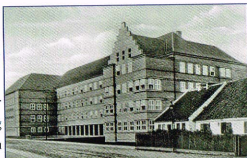
Das Schulgebäude an der Deutschordenstraße (nun Woljka Polskiego) wurde am 16. Oktober 1930 feierlich eröffnet.
